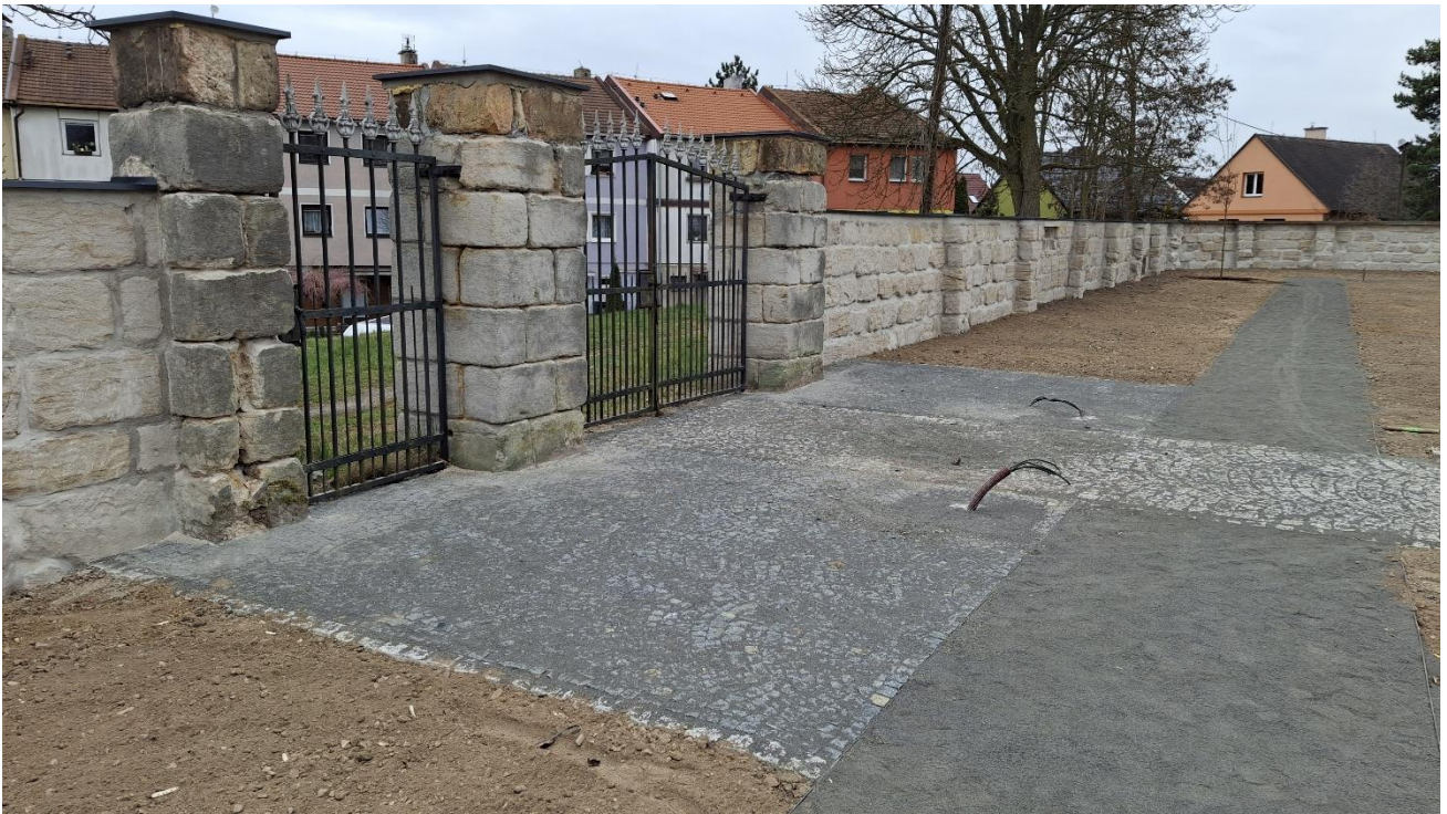
Stávající vstup v jižním oplocení s vydlážděnou nástupní plochou
