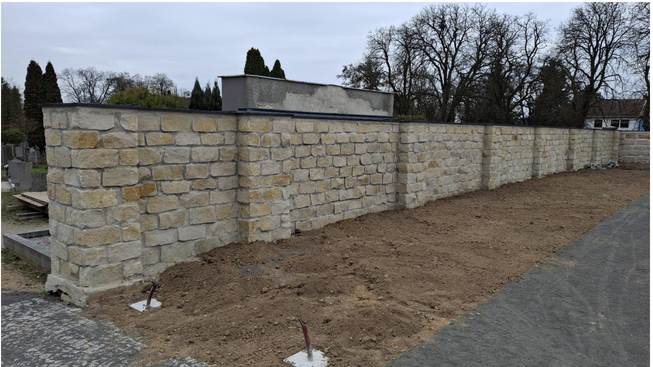
Opravená/nově vyzděná pískovcová zeď mezi oběma částmi hřbitova
