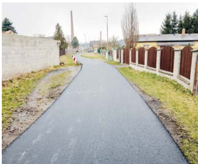
Opravená spojka silnic ul. Skřivánčí a ul. Ralská
