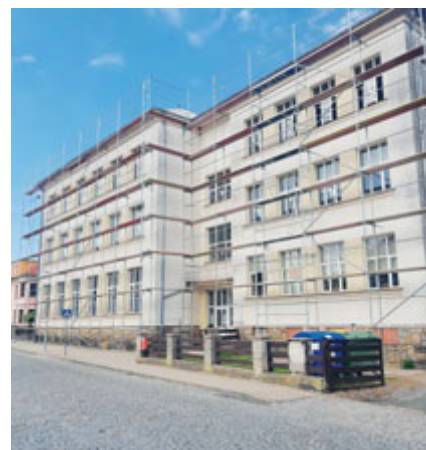
Začala výměna krytiny celé střechy ZŠ Komenského
