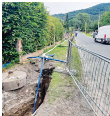
Začala poslední etapa opravy řadu ve Vranově pod Ralskem
