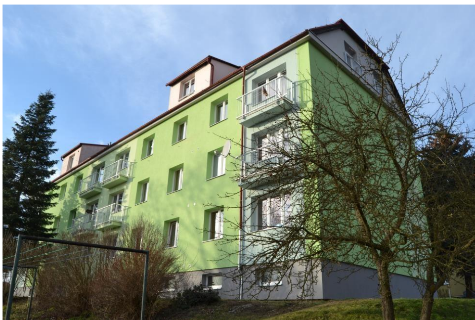
Obrázek č. 33 – Zateplení obvodového pláště a výměna výplní bytového domu Letná 255 a 256
