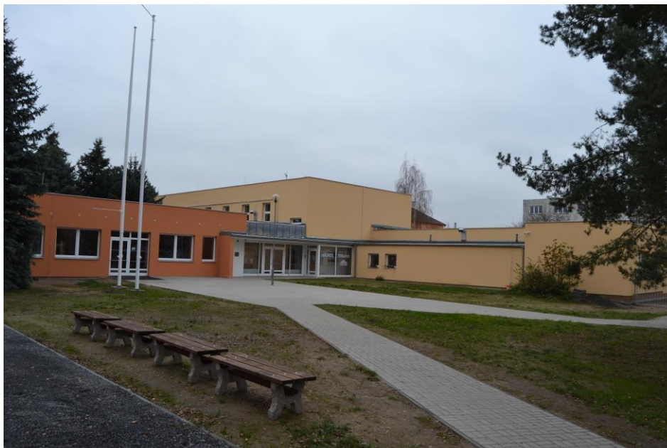
Obrázek č. 33 – Zateplení obvodového pláště a výměna výplní bytového domu Letná 255 a 256
