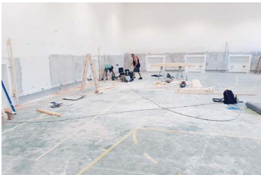
Oprava tělocvičny ZŠ Mimoň, budovy Mírová
